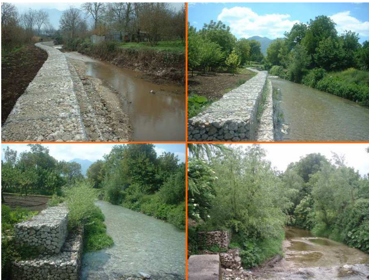
Rinverdimento gabbionate in fasi temporali successive
